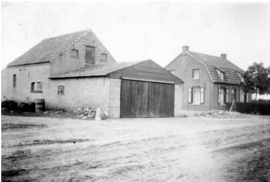
De maalterij en het woonhuis van mùlder Johannes de Visscher op Loo.
