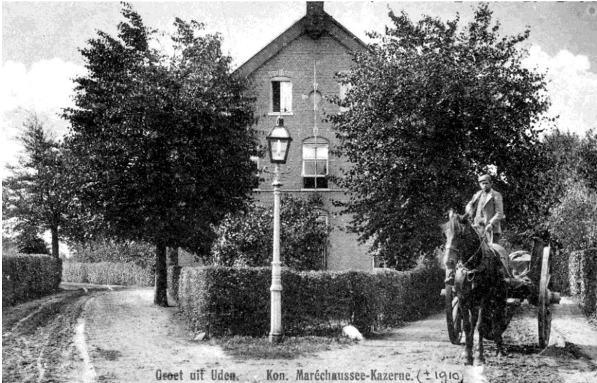
Fig. 5: Het brigadegebouw omstreeks 1910. Het zicht op de toegangsdeur werd belemmerd door enkele struiken. Van wegverharding was nog geen sprake.
